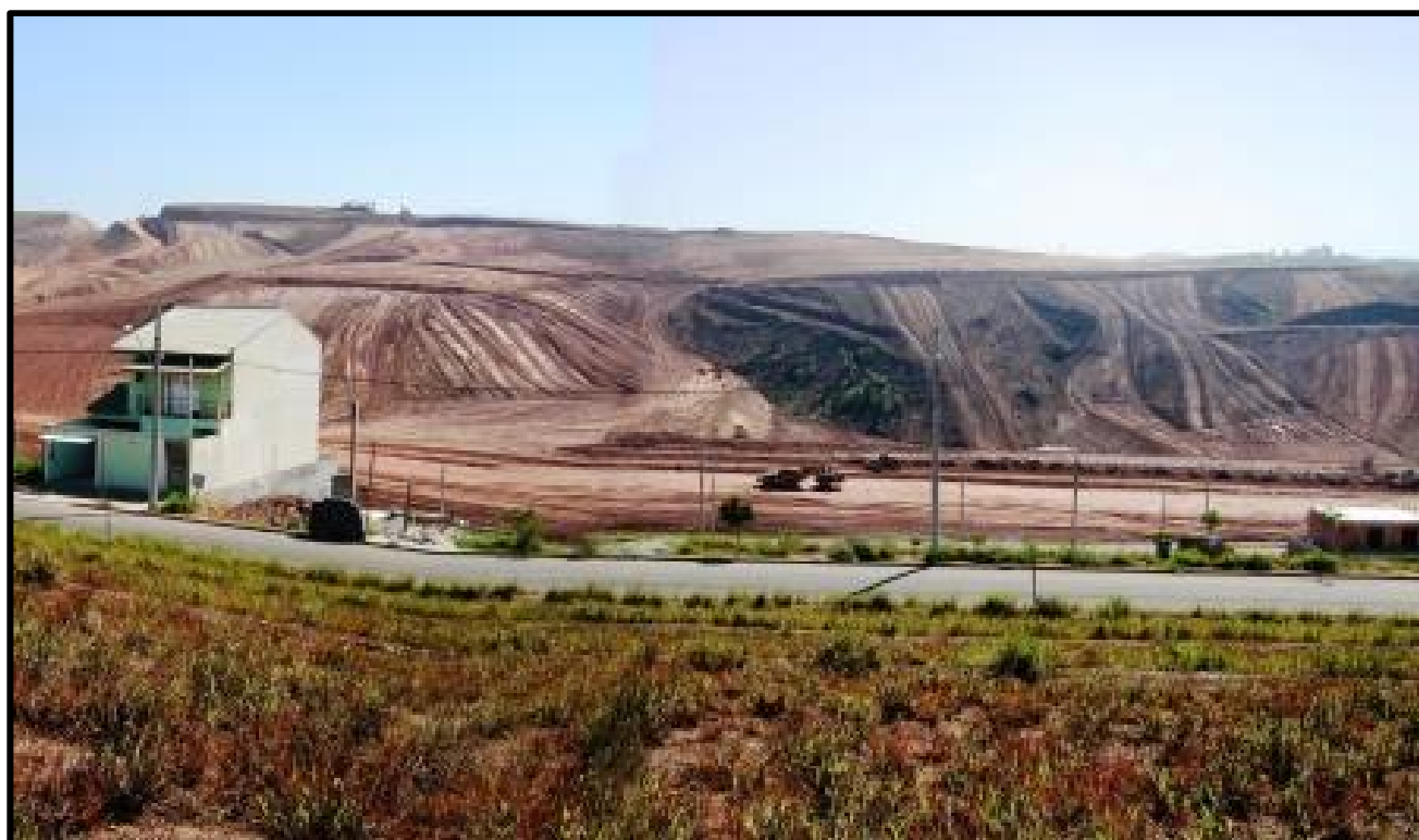
Terraplenagens excessivas e sem nenhum controle maior da erosão e do assoreamento.
