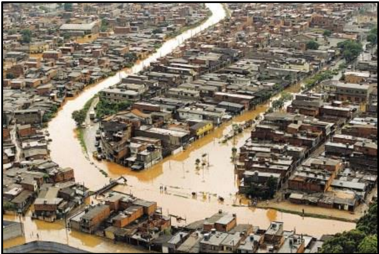
Bairros instalados em áreas baixas sem cuidados hidráulicos de proteção.
